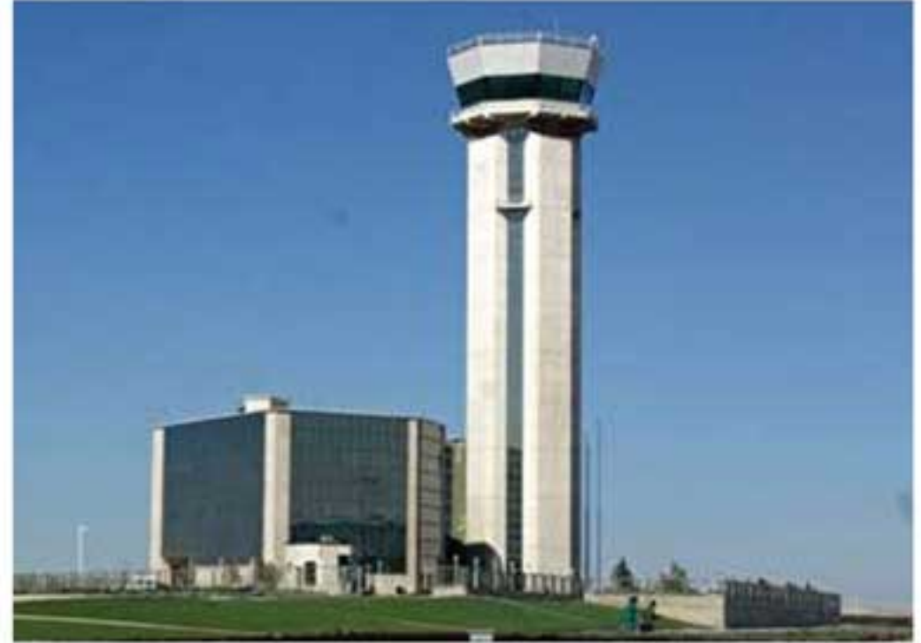
برج مراقبت فرودگاه امام خمینی
