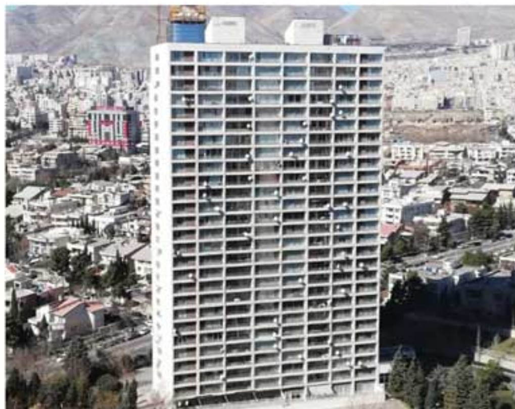
برج پاسارگاد شهرک غرب
