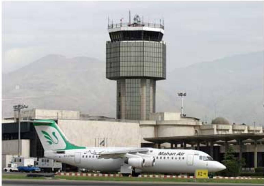
برج مراقبت فرودگاه مهرآباد
