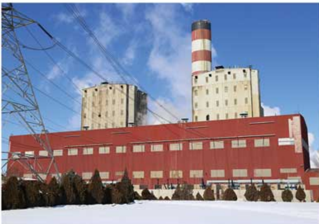
نیروگاه حرارتی تبریز
